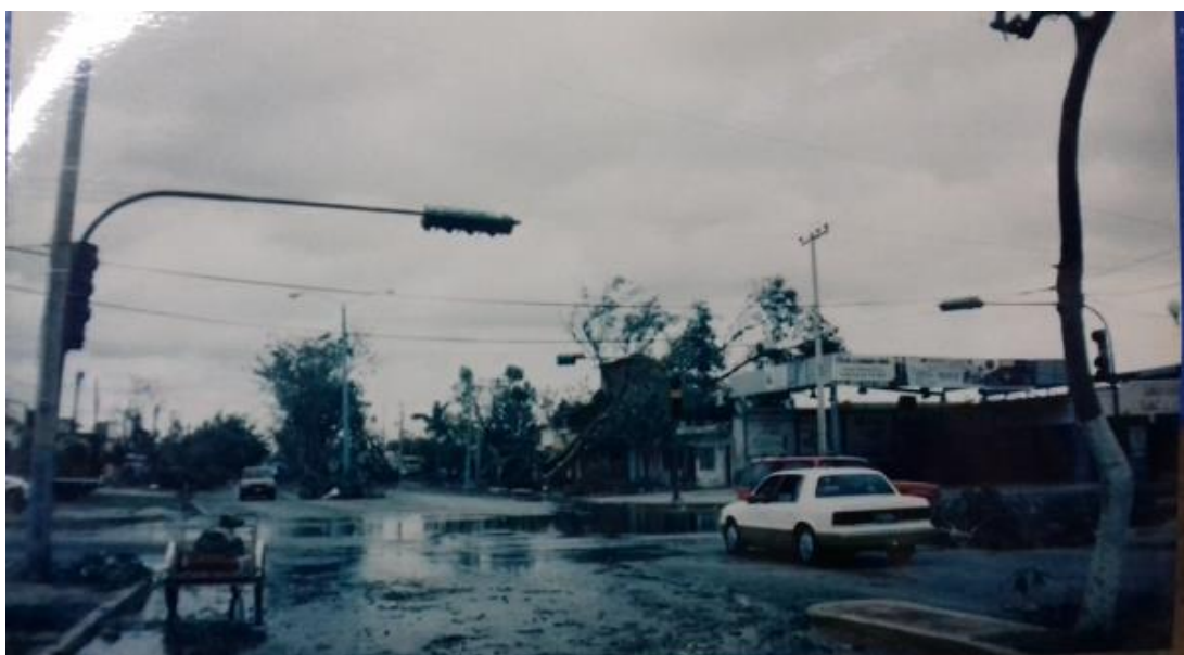
Imagen 1. Daños causados en espacios públicos tras el paso del huracán Dean (2007).
